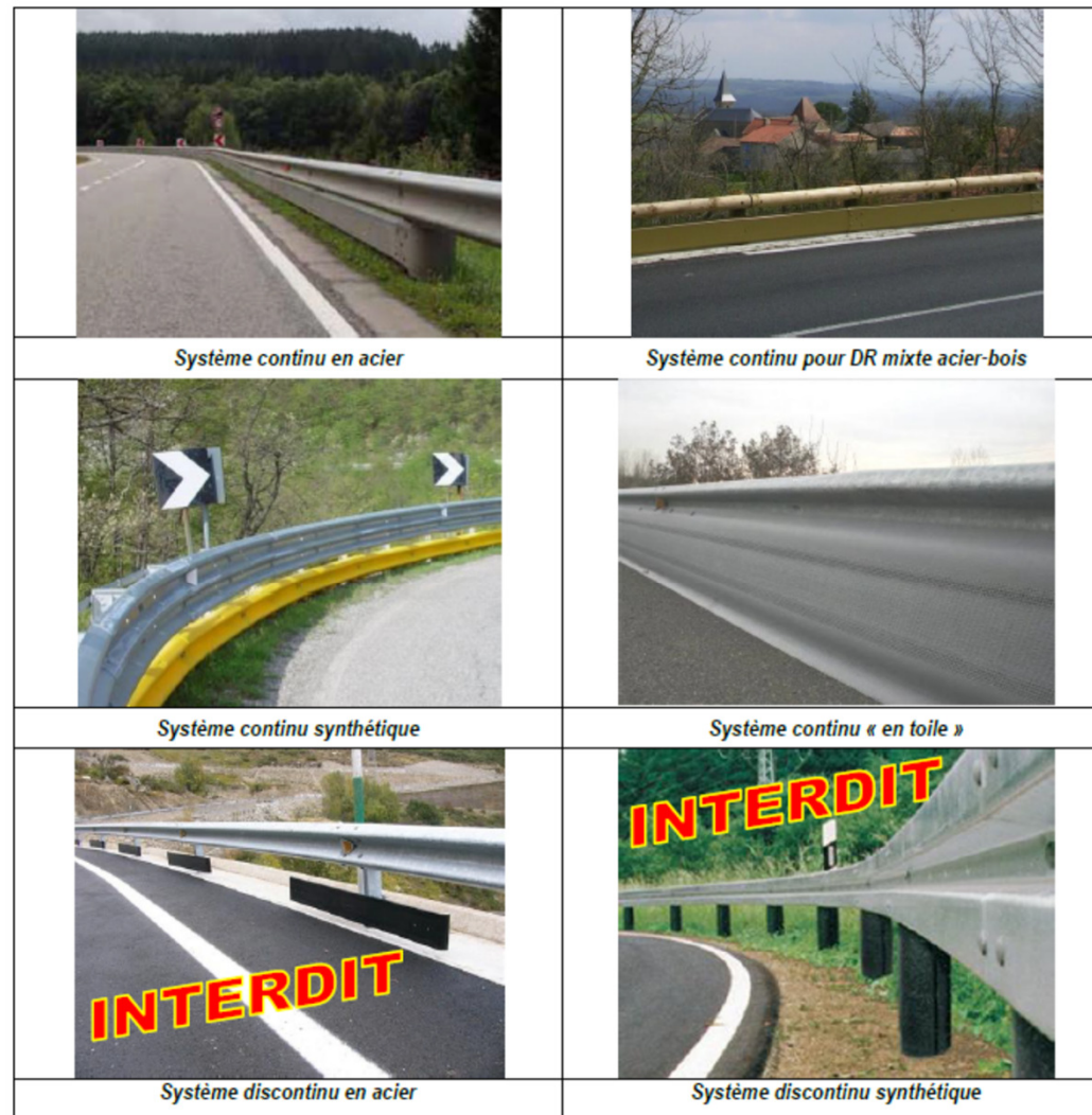
Figure 58 – Exemples de système de protection motocycliste.
