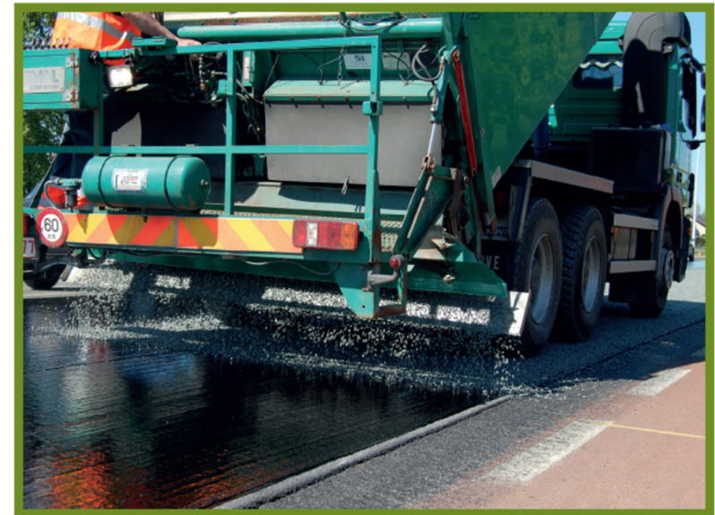
Figure 3 – Gravillonnage d'un SAMI
