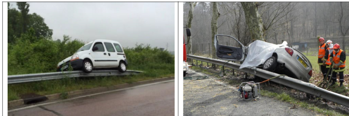
Figure 38 – Conséquences d'accident contre une extrémité enfoie dans le sol.
