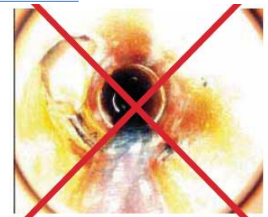
Raccordement par perçage buriné
