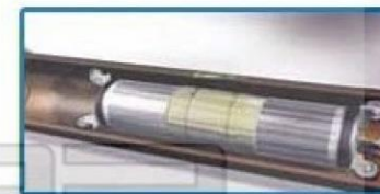
que nous plaçons au droit du défaut
