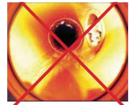
Raccordement non étanche
