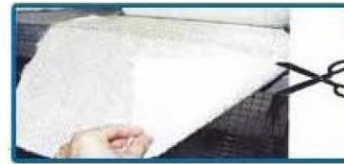
la pièce de fibre de verre est coupée selon la taille de la manchette
