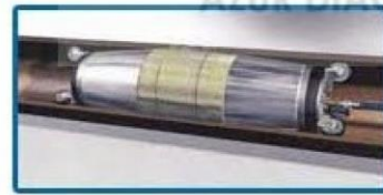
le packer est gonflé, et gardé sous pression pendant le temps de sèche
