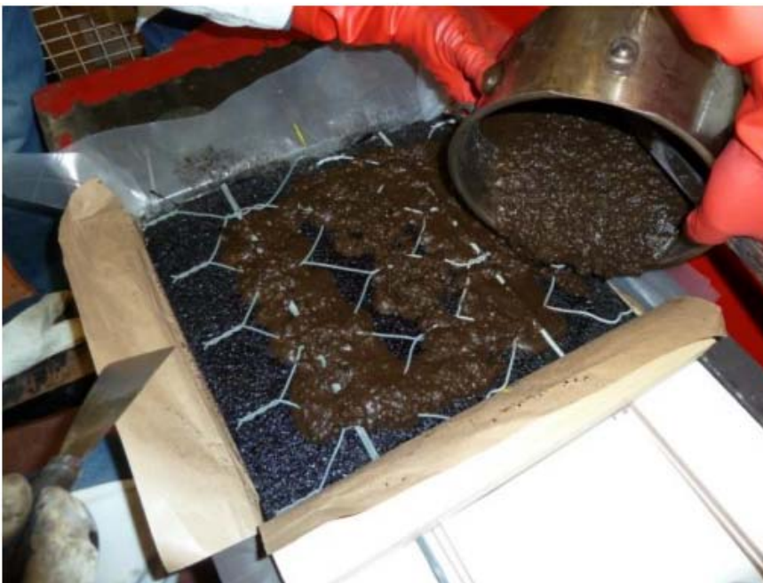
Figure D : Application couche slurry seal (note : 2 échantillons de treillis d'armatures en acier sont appliqués)
