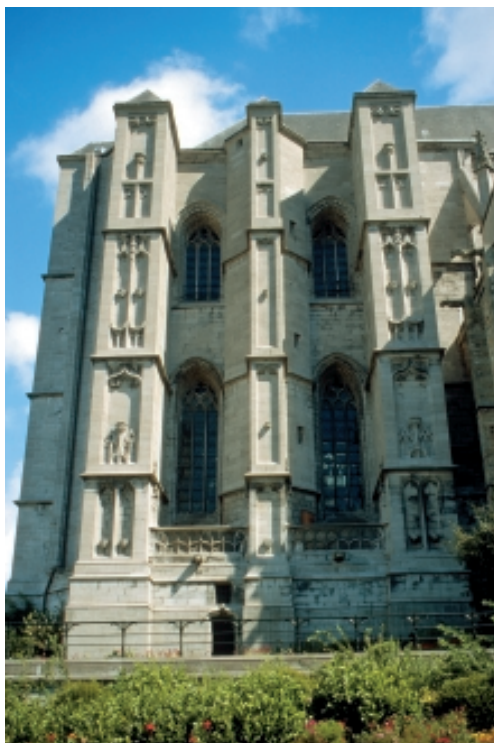
Fig. 1 Collégiale Sainte-Waudru à Mons (reconstruite en 1450 en pierre bleue de Belgique et grès de Bray).
