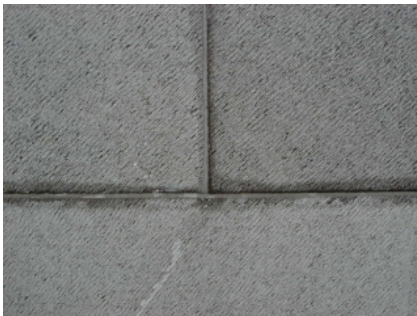
Fig. 39 Tachage de mastics silicones.
