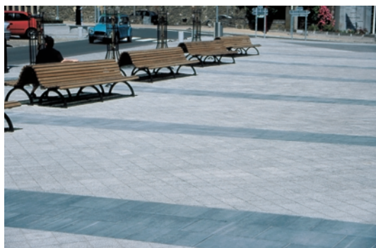
Fig. 37 Vue générale d'un dallage de voirie.
