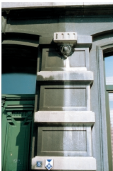
Fig. 38 Nettoyage de façade.
