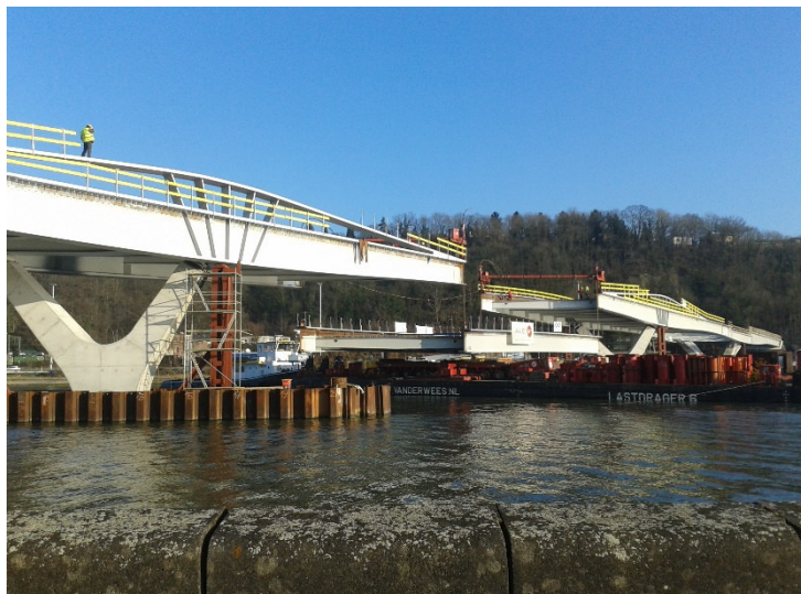
Suivi technique d'exécution et de montage sur chantier.
