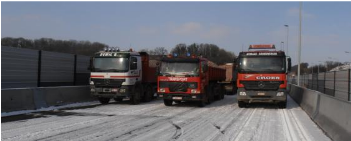
FIGURE 4 : MISE EN CHARGE D'UNE TRAVÉE DU VIADUC DE BOIRS
