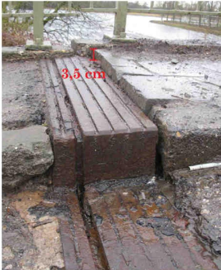
FIGURE 48 : MOUVEMENT VERTICAL AU NIVEAU DU JOINT DE 3,5 CM EN AMONT
