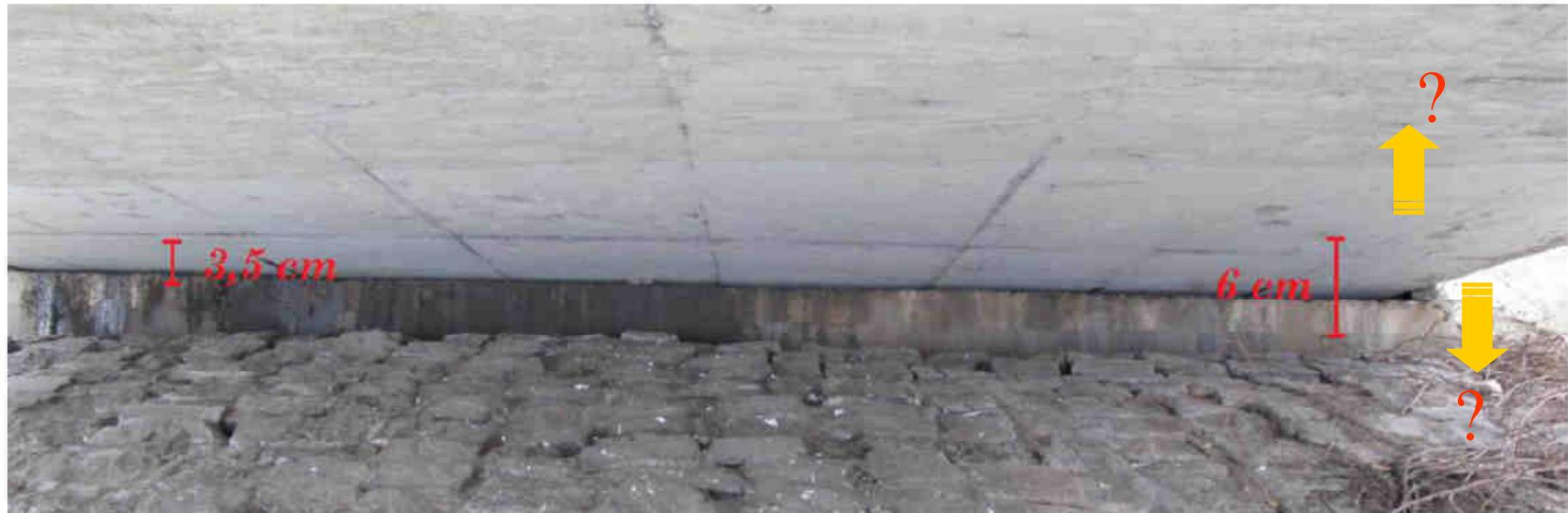
FIGURE 49 : MOUVEMENT VERTICAL ENTRE LE SOMMIER ET LE TABLIER
