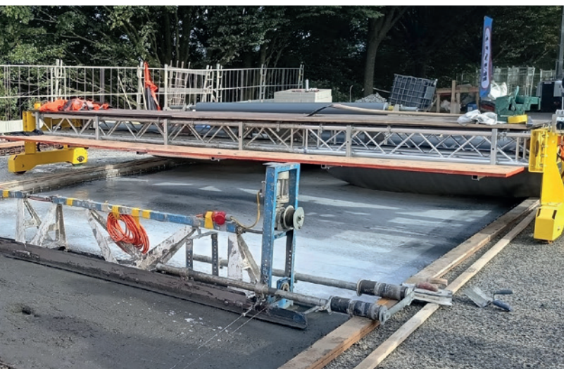
Figure 3 : Bétonnage chantier - phase 1
