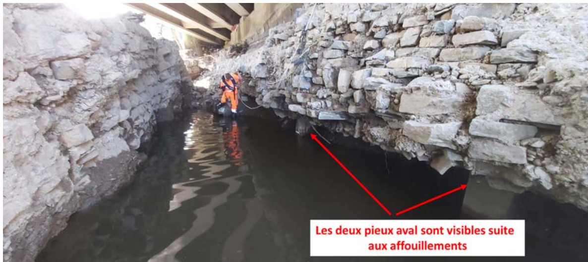
- Inspection de la culée en rive droite du pont du Square Gramme à Liège -
