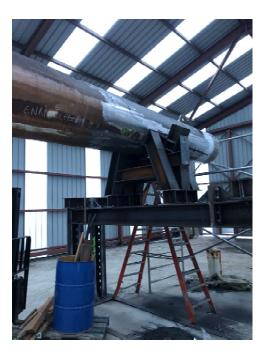
Sa principale particularité est qu'il n'est pas ancré dans le béton mais bien déposé sur un socle, formant une rotule, permettant au mât de bouger au gré des mouvements du pont liés aux surcharges d'exploitation et à la dilatation.
