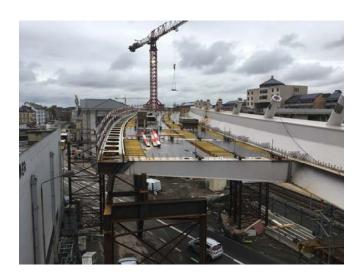
Le caisson principal fut fabriqué et posé en 4 parties puis soudé en position. 3 éléments sur 4 étaient pourvus de tubes servant d'accroches pour les haubans.
