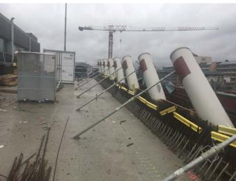
Lors de la pose de cette pièce, une importance particulière fût de mise sur la précision des tubes devant être positionnés et orientés au millimètre par rapport à la position des oreilles du mât qui n'étaient pas présentes physiquement. Pour s'assurer que ce réglage ne bouge lors du bétonnage, les tubes ont dû être bloqués un à un par un étançon permettant également un réglage transversal fin.
