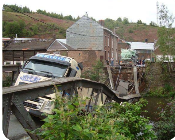
Effondrement du pont de Trooz en 2011
