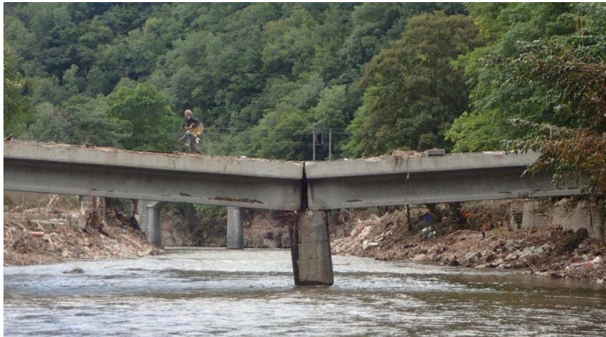
En première phase, toutes les situations urgentes ont été traitées
