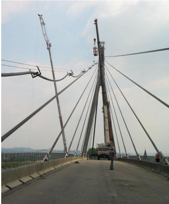
2004 – démontage du hauban défectueux Ruptures de fils repérées lors de l'expertise
