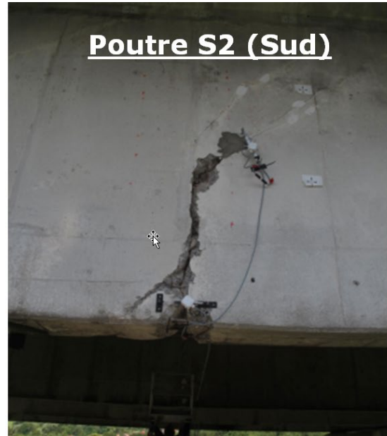
Capteurs de déplacement mis en place pour le suivi des fissures
