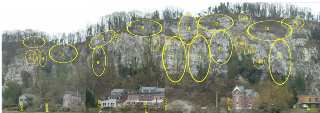
Inspection sur site et définition de zones à conforter.
