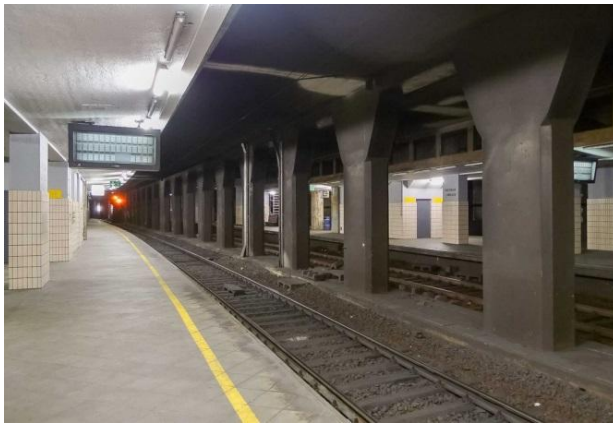
Figure 6: Situation avant travaux - structure ouverte
