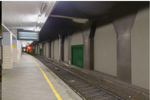
Figure 7 : Situation après travaux - Compartimentage et porte coulissante
