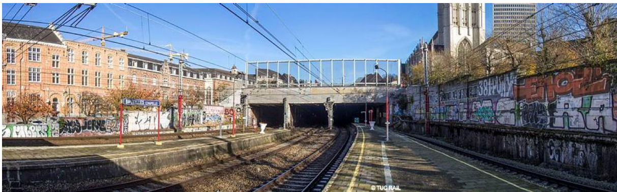
Figure 9 : tête sud du tunnel
