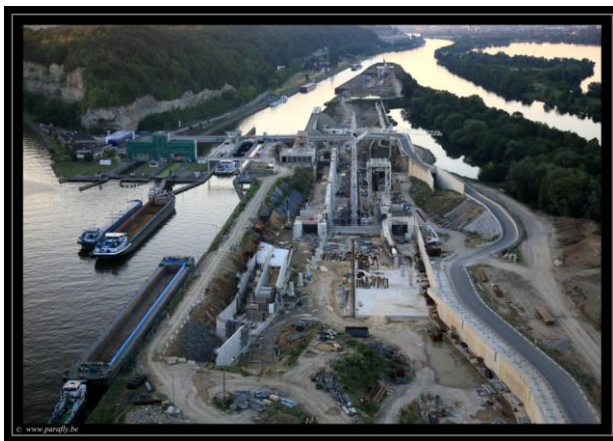
Figure 1 : chantier 4 ème écluse juillet 2014 (photographie de www.paraflly.be )
