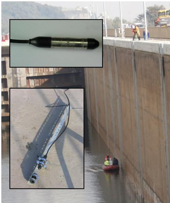
Figure 4 : Mise en place des sondes de pression
