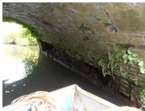
Figure 3. - Pont de Lobbes : vue de l'intrados de la voûte
