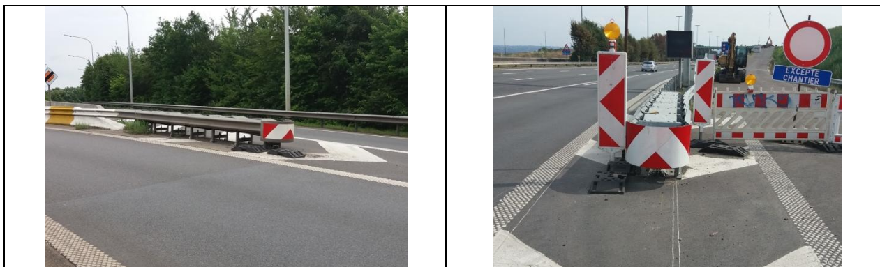
Figure 48 – Exemples d'atténuateurs de choc.
