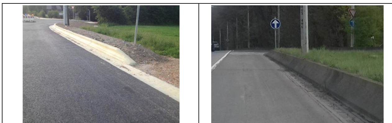
Figure 7 – Bordures basses en béton
