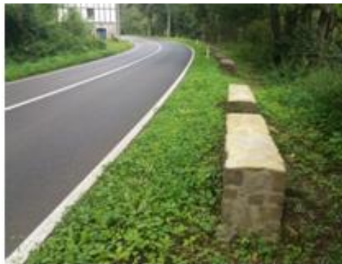
Figure 9 – Murets en maçonnerie.
